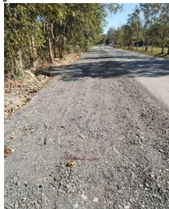
รูปถ่ายดำเนินการก่อสร้างแล้วเสร็จ
