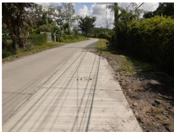
รูปถ่ายดำเนินการก่อสร้างแล้วเสร็จ
