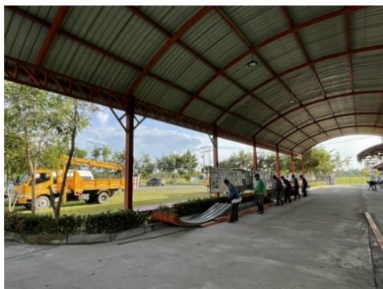
รูปถ่ายก่อนดำเนินการก่อสร้าง
