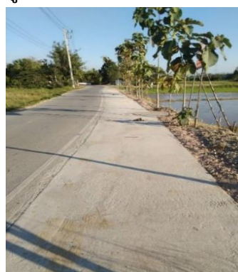
รูปถ่ายดำเนินการก่อสร้างแล้วเสร็จ
