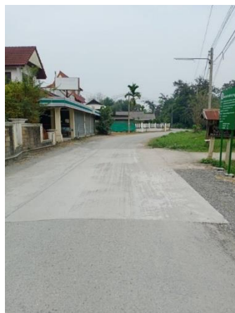
รูปถ่ายดำเนินการก่อสร้างแล้วเสร็จ
