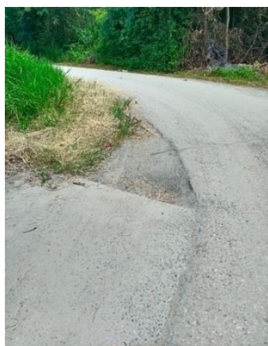
รูปถ่ายก่อนดำเนินการก่อสร้าง
