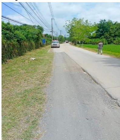
รูปถ่ายก่อนดำเนินการก่อสร้าง
