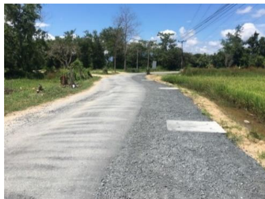
รูปถ่ายดำเนินการก่อสร้างแล้วเสร็จ
